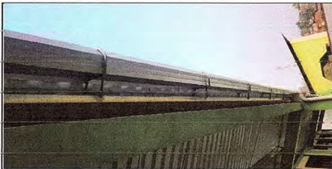
Foto 3: La imagen muestra la canalización de aguas pluviales, totalmente nueva, utilizando canales galvanizados
