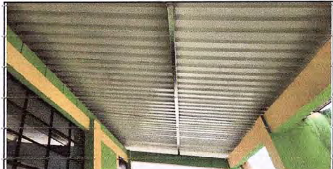
Foto 2: Aquí se puede ver como quedó la cubierta, utilizando materiales de calidad
