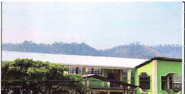
Foto 6: En esta fotografía se aprecian los trabajos terminados al 100%
