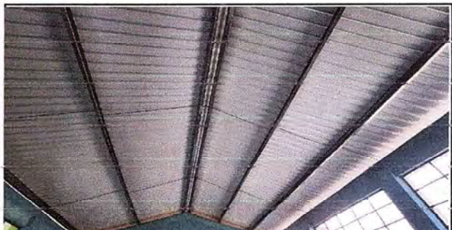
Foto 4: Esta es una fotografía de uno de los salones de clase, con la cubierta de lámina troquelada calibre 26 y costaneras galvanizadas, totalmente nueva
