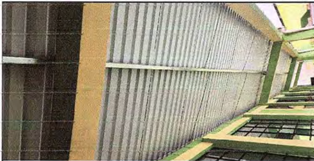
Foto1: En esta fotografía se aprecia el corredor del edificio con cubierta de lámina totalmente nueva
